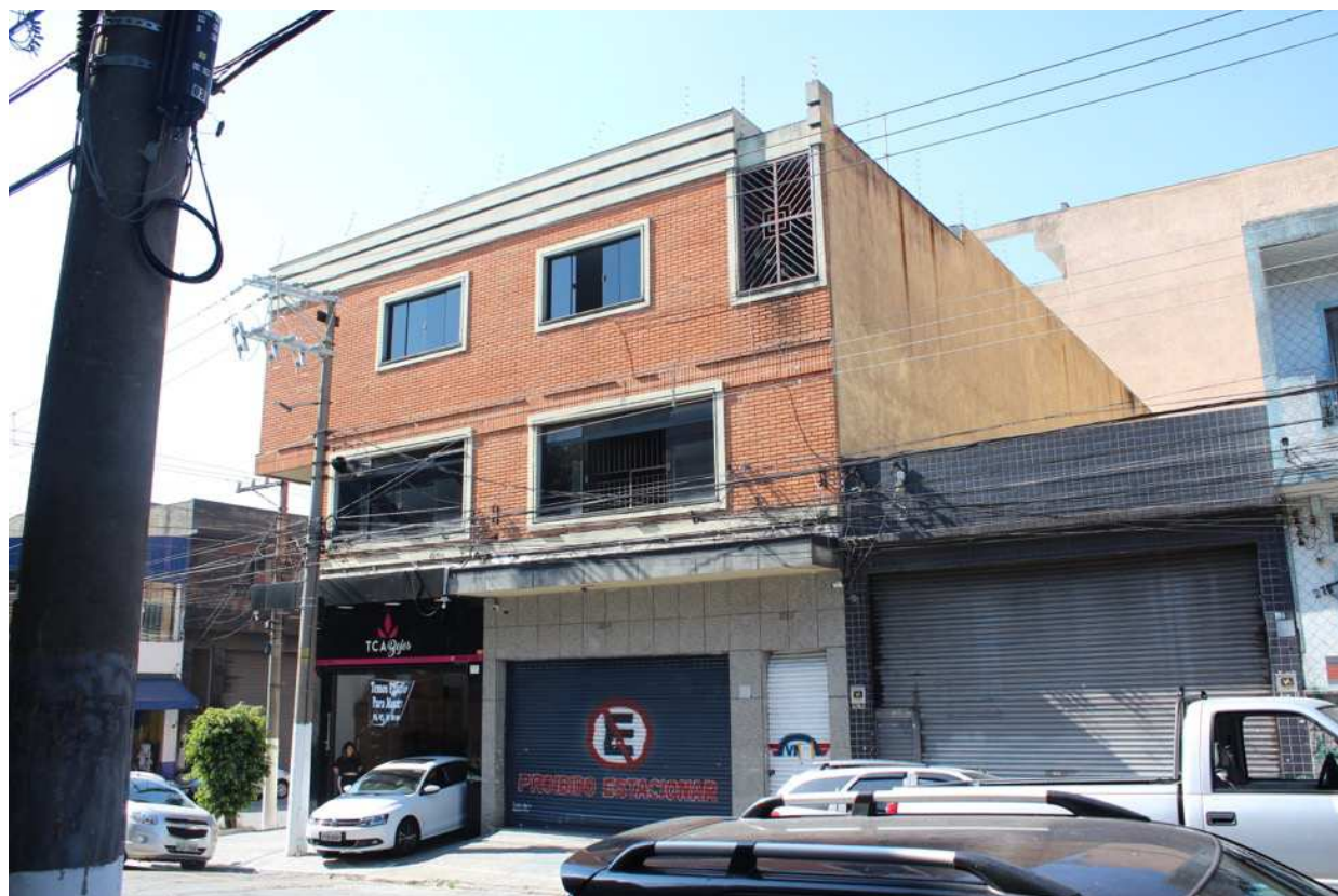
Situação Paradigma – Rua Souza Caldas, 282/284
