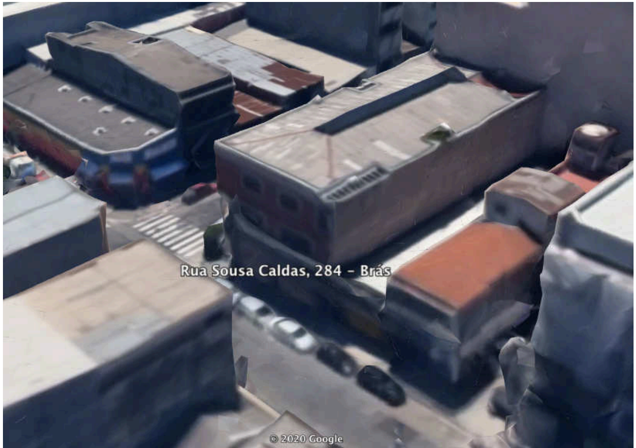
Situação Paradigma – Rua Souza Caldas, 282/284
