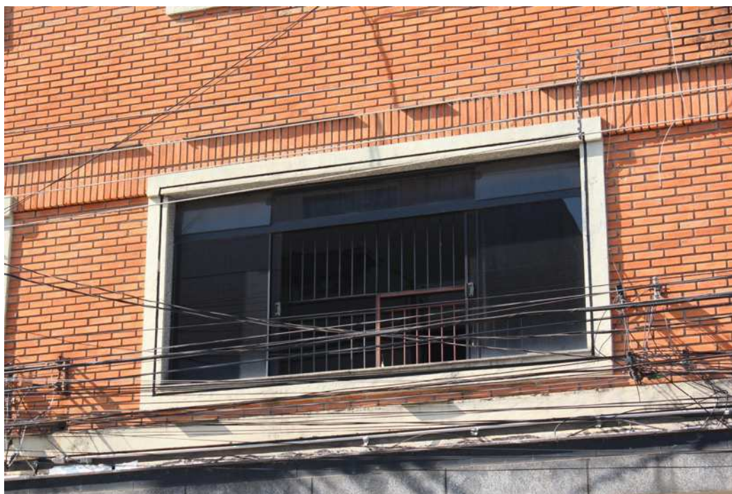
2º Pavimento com janelas abertas
