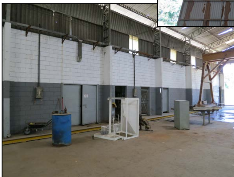
Fotos 18, 19 e 20: Vistas do Galpão (área de produção).
