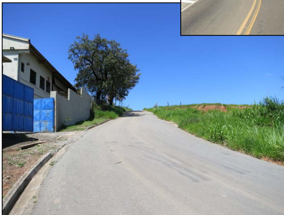
Fotos 01 e 02: Vista parcial da estrada Rosa Scarpa, próxima ao imóvel avaliando. No destaque, vista parcial da estrada dos Romeiros.
