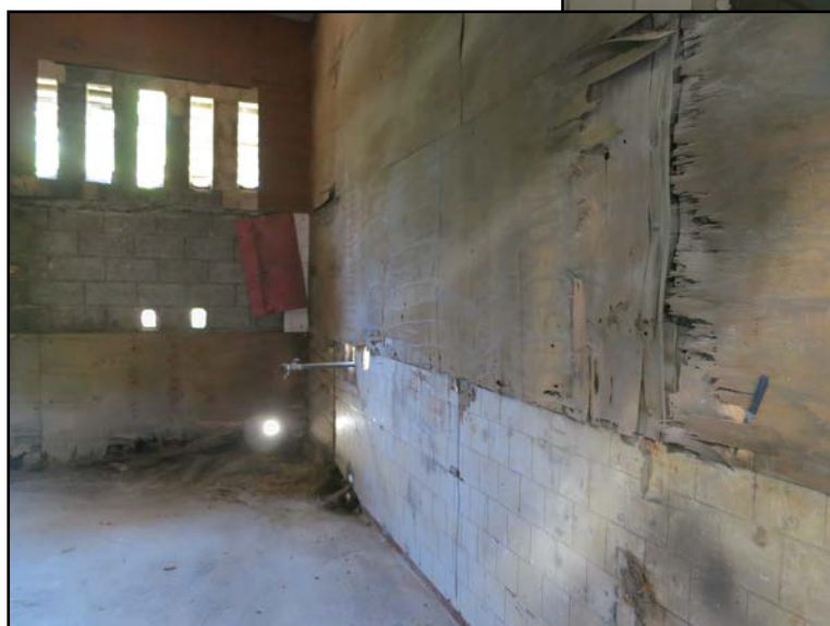
Fotos 30, 31 e 32: Vistas do Galpão (área de apoio).
