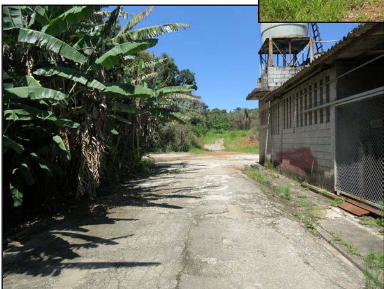
Fotos 08, 09 e 10: Vistas das áreas externas do imóvel.
