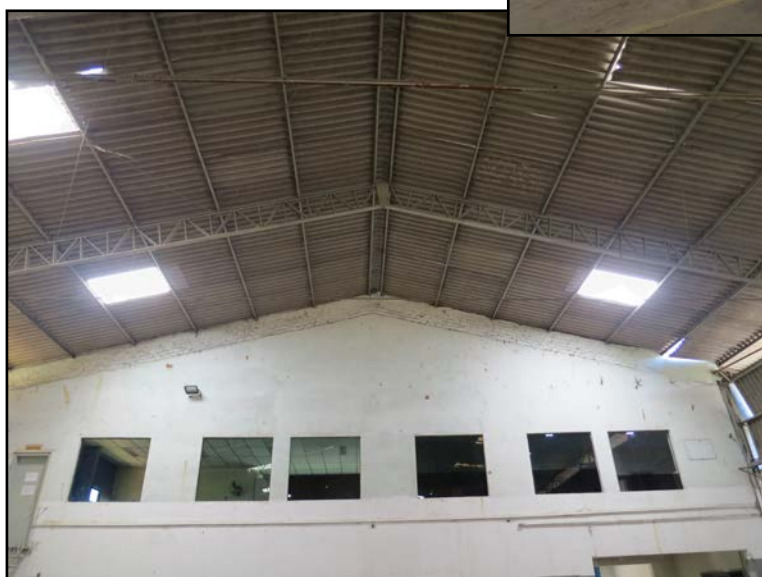
Fotos 21, 22 e 23: Vistas do Galpão (área de produção).
