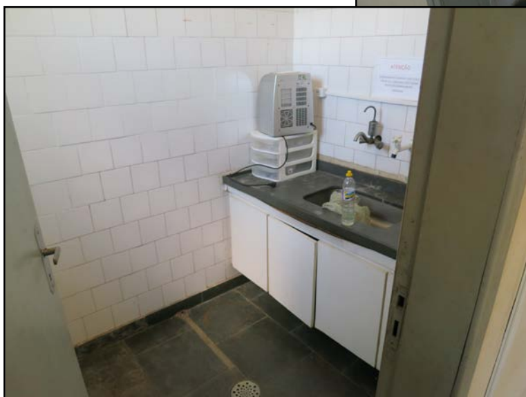
Fotos 39, 40 e 41: Vistas do Galpão (administrativo e serviço).
