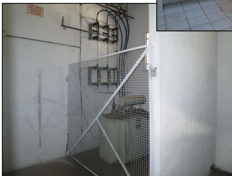
Fotos 24, 25 e 26: Vistas do Galpão (área de apoio).
