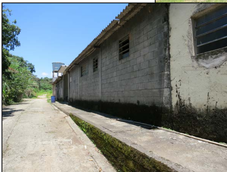
Fotos 05, 06 e 07: Vistas das áreas externas do imóvel.
