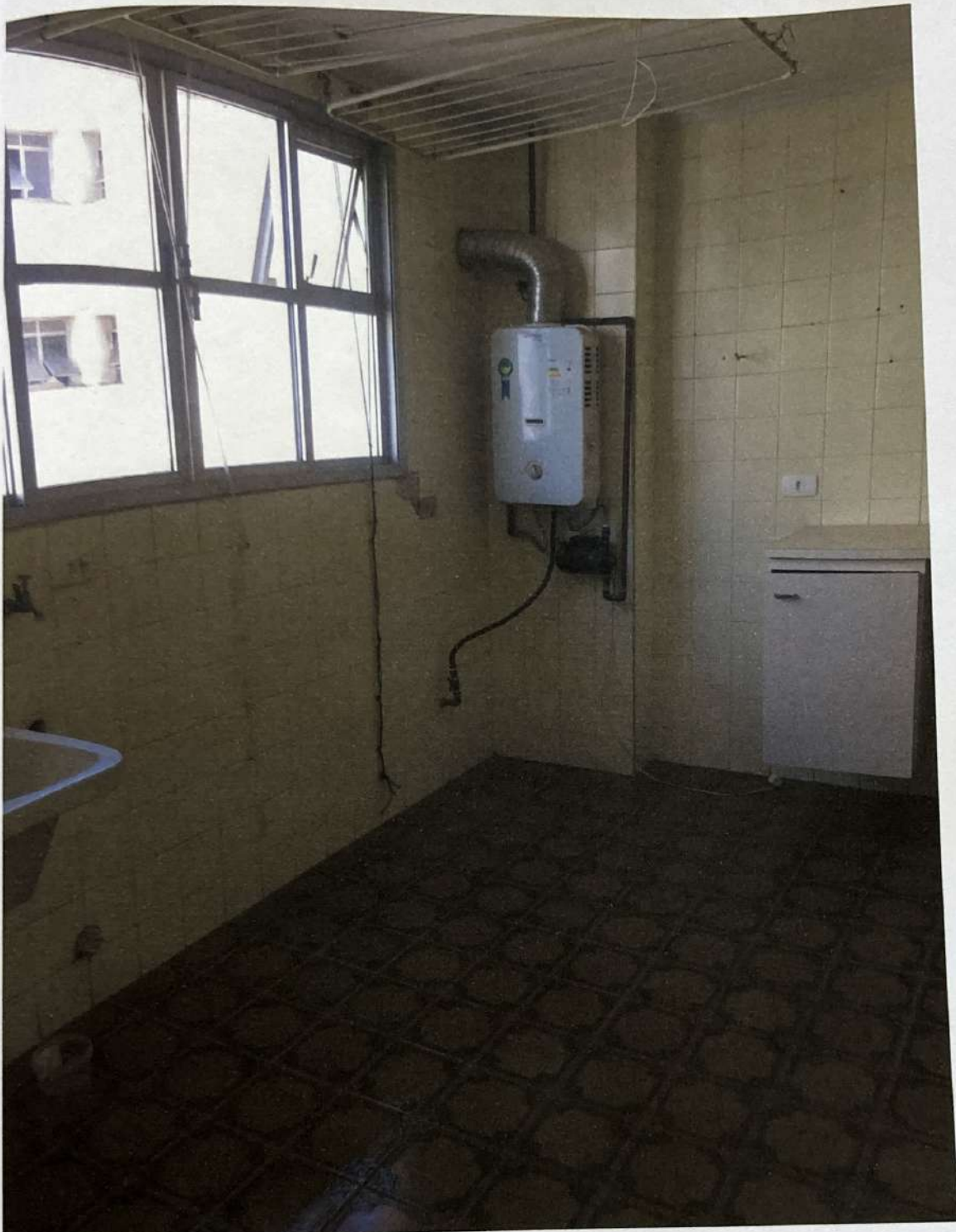
FOTO 6: Área de Serviço - Avaliando
