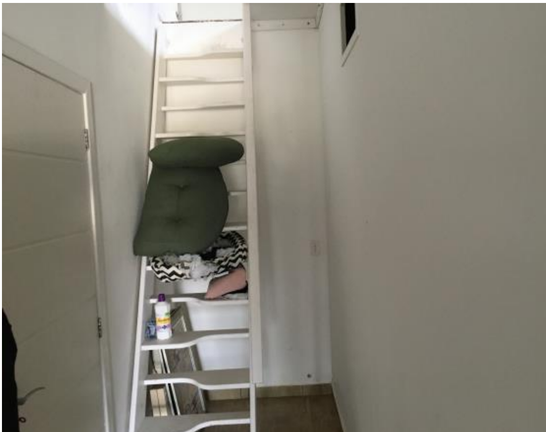
VISTA DA ESCADA DE ACESSO AO SÓTÃO.
