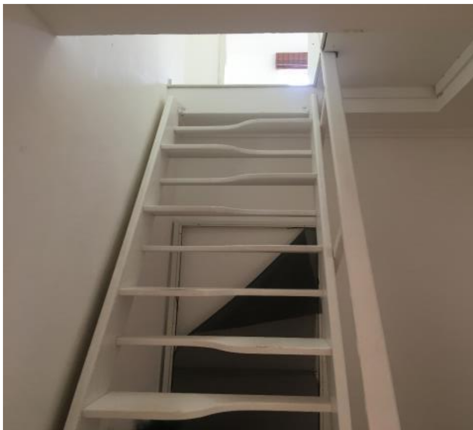
VISTA DA ESCADA DE ACESSO AO SÓTÃO.
