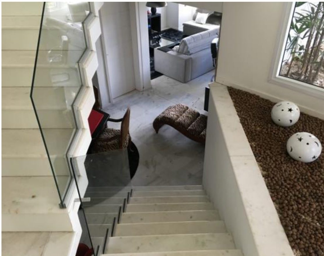
VISTA DA ESCADA DE ACESSO AO PAVIMENTO INFERIOR.
