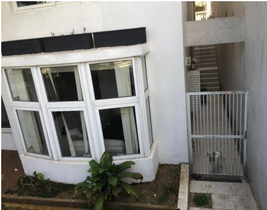
VISTA DO CORREDOR DO IMÓVEL.
