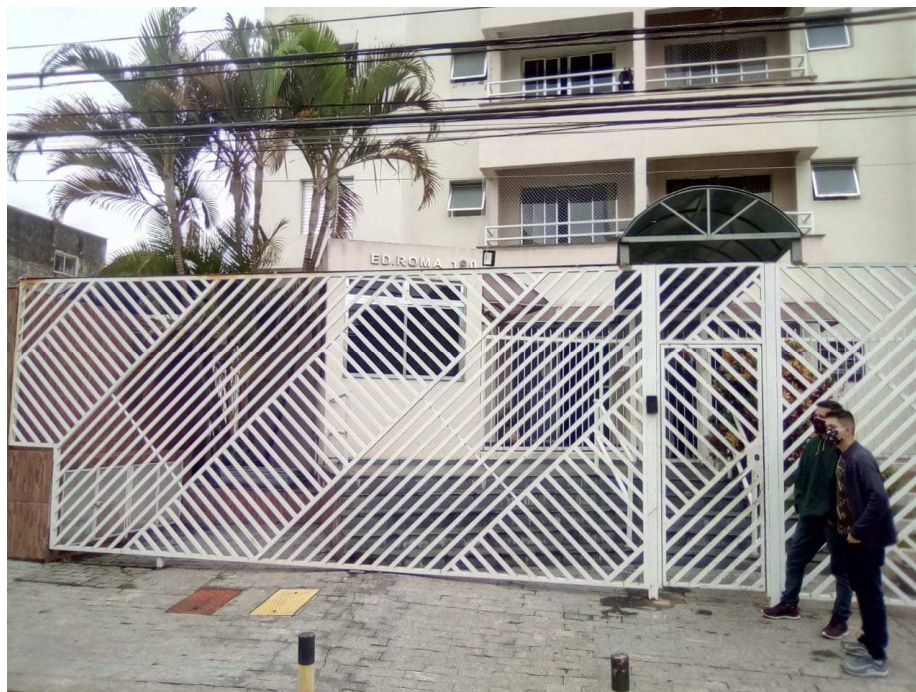
VISTA DA ENTRADA DO EDIFÍCIO.
