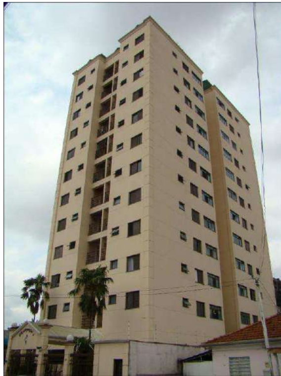
A foto ilustra as fachadas do Condomínio Edifício Residencial Flamingo.
