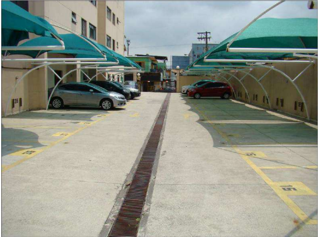
A foto ilustra o estacionamento com as Vagas da Garagem.
