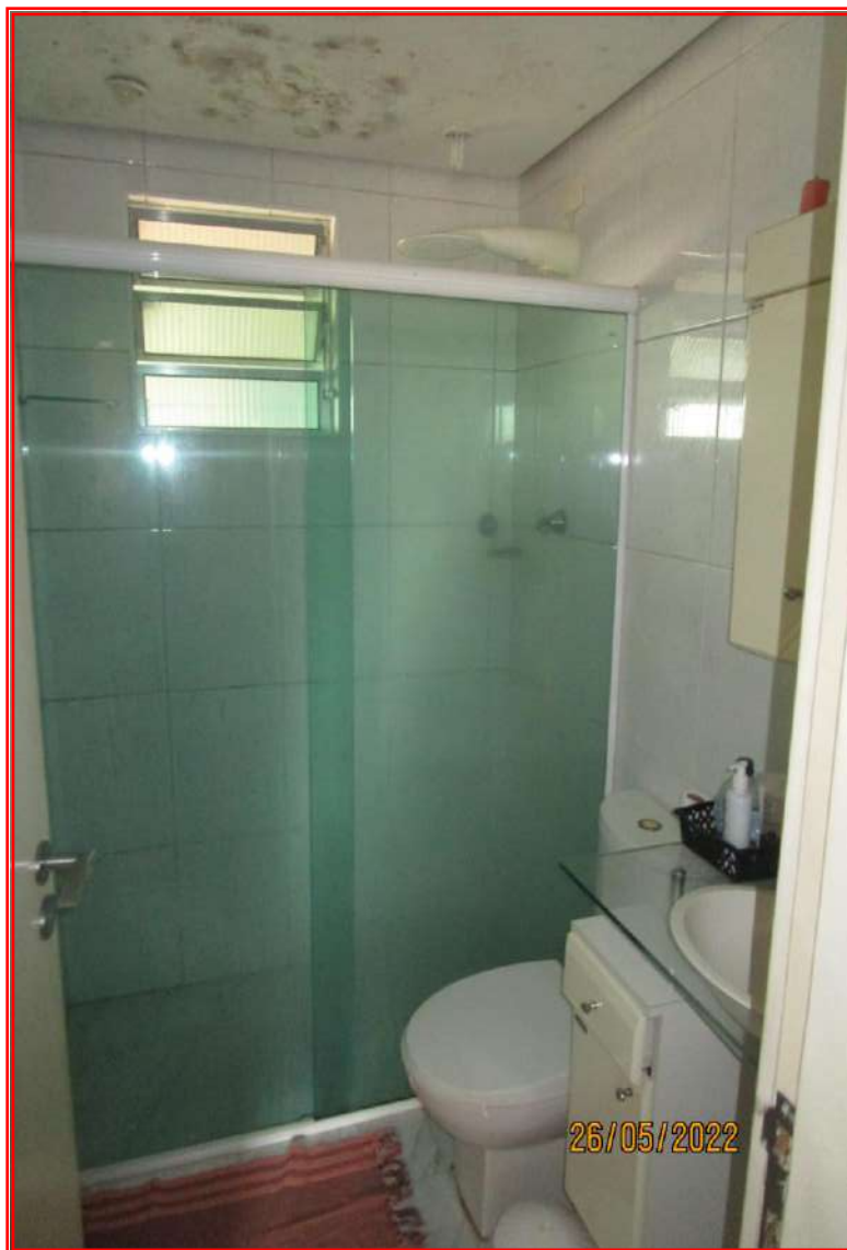
Foto nº 18: Vista parcial do banheiro 02.
