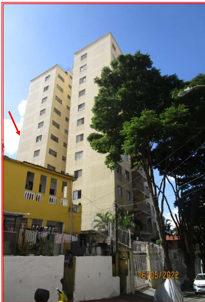
Foto nº 02: Outra vista geral do Condomínio Edifício “Monte Carlo”. A seta indica a posição da fachada para qual o imóvel possui vista panorâmica.
