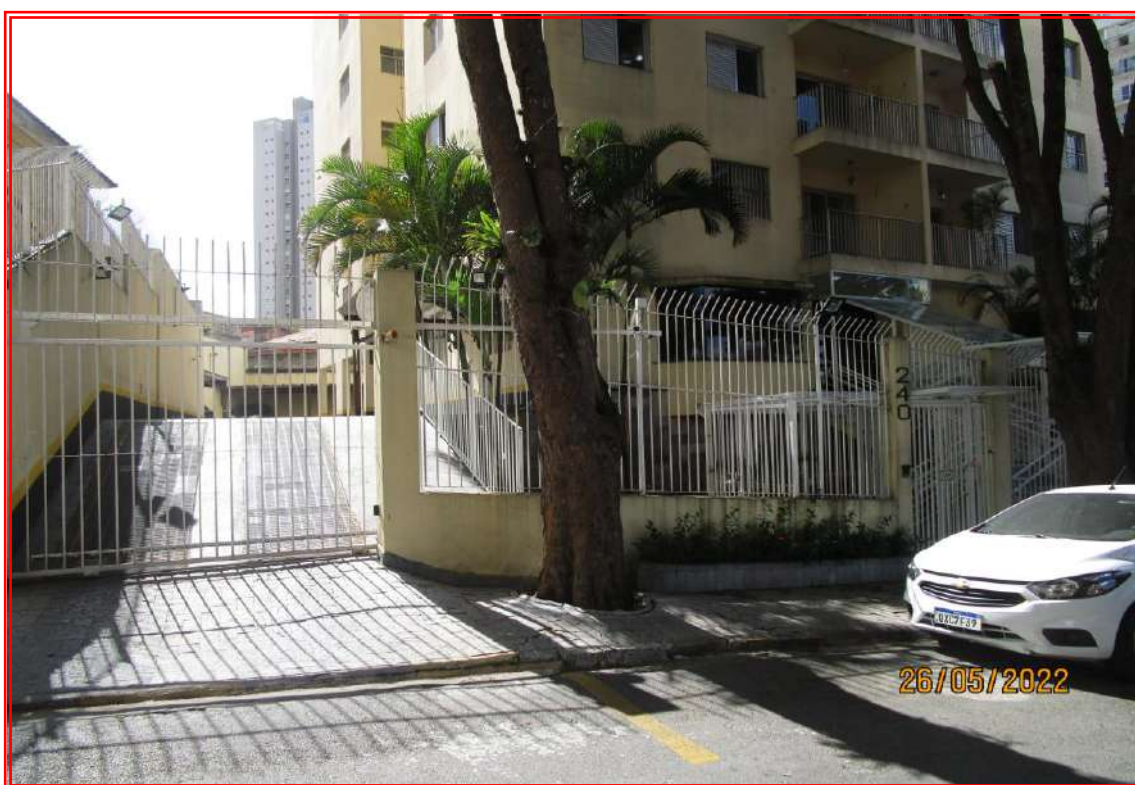
Foto nº 03: Vista geral da rampa de acesso ao subsolo destinado ao estacionamento.
