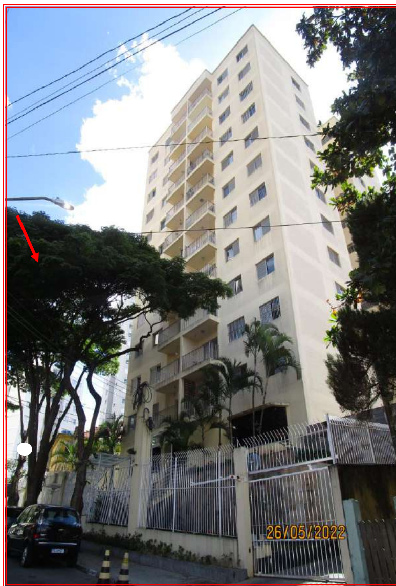
Foto nº 01: Vista geral do Condomínio Edifício “Monte Carlo”, onde se localiza o imóvel avaliando.
