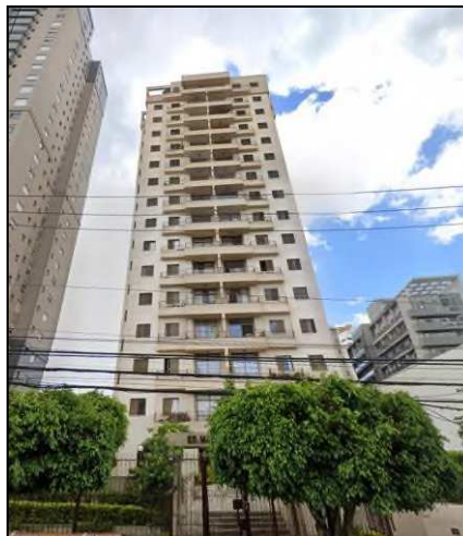
Edifício Monte Ararat
