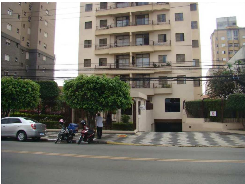
A foto ilustra a guarita e a entrada da garagem (subsolos) do Edifício Monte Ararat situado na Avenida Santo Antônio nº 1.291.
