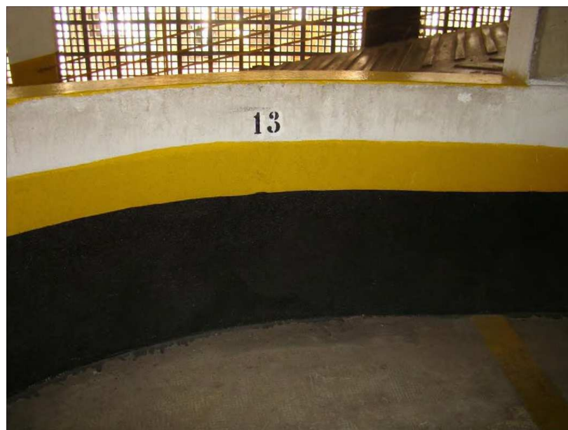
FOTO DA VAGA Nº 47 - Nº 13 NO LOCAL
