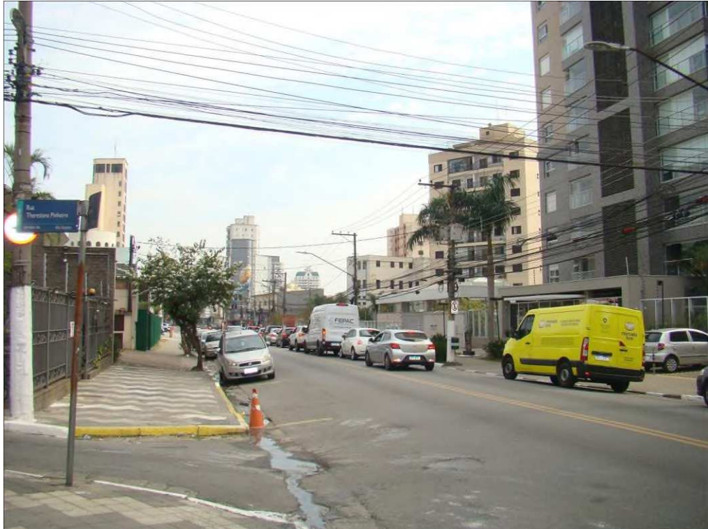
A foto ilustra a Avenida Santo Antônio na altura do nº 1.291, Vila Osasco - Osasco/SP, onde está situado o Edifício Monte Ararat.
