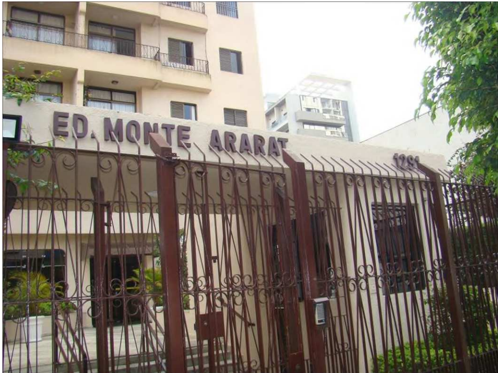
A foto ilustra a guarita do Edifício Monte Ararat situado na Avenida Santo Antônio nº 1.291.
