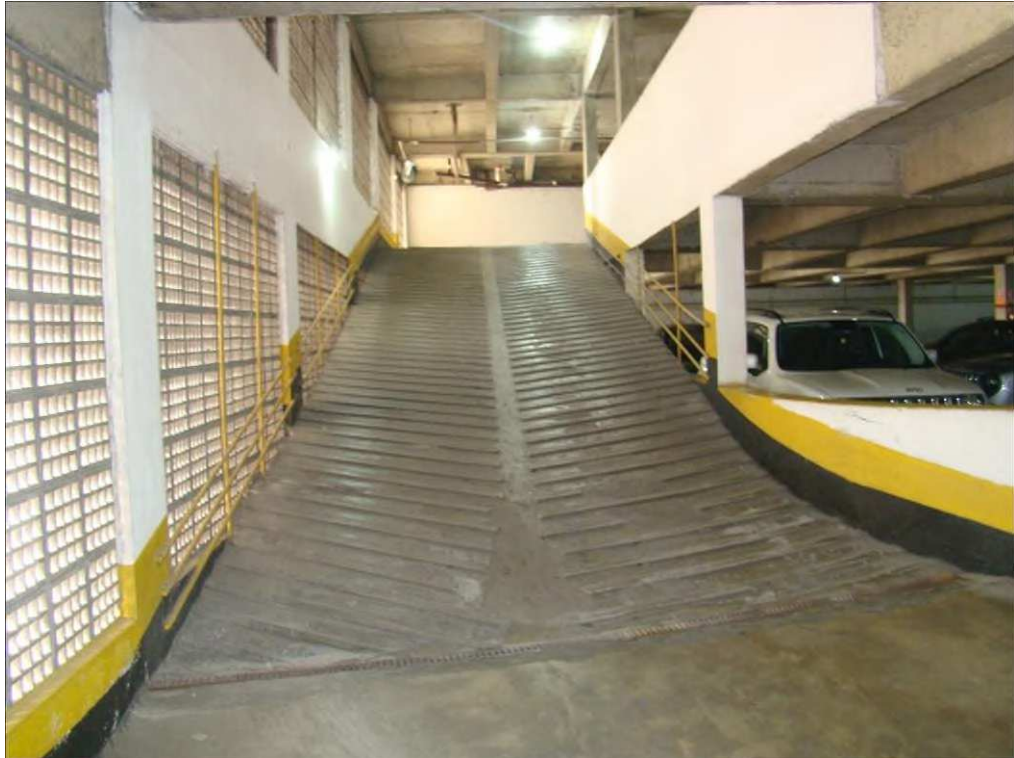
A foto ilustra a rampa de acesso ao 1º subsolo, junto a vaga nº 47 (nº 13 no local) no 2º subsolo do Edifício Monte Ararat.
