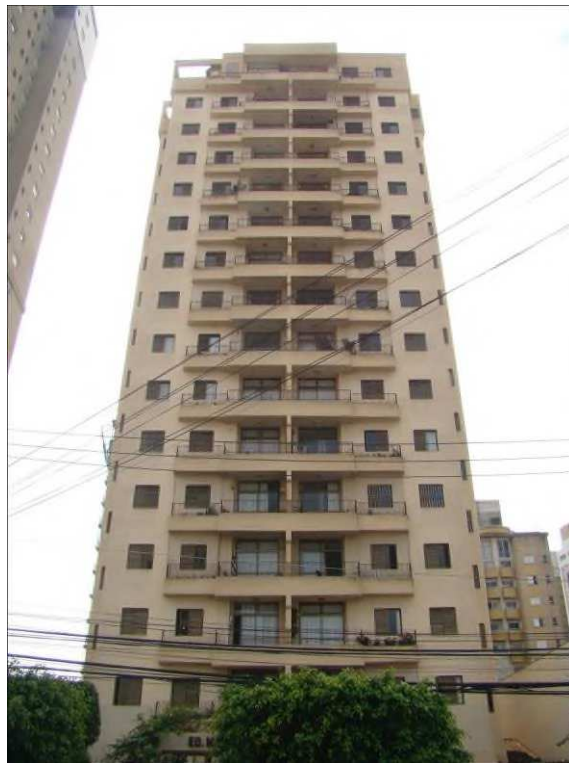
A foto ilustra a fachada frontal do Edifício Monte Ararat.
