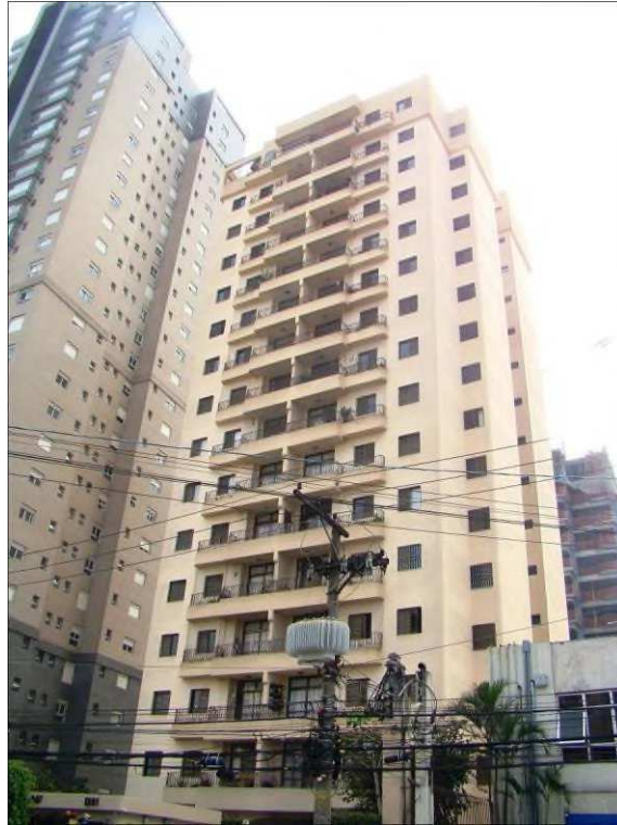
A foto ilustra o Edifício Monte Ararat situado na Avenida Santo Antônio nº 1.291, Vila Osasco - Osasco/SP.
