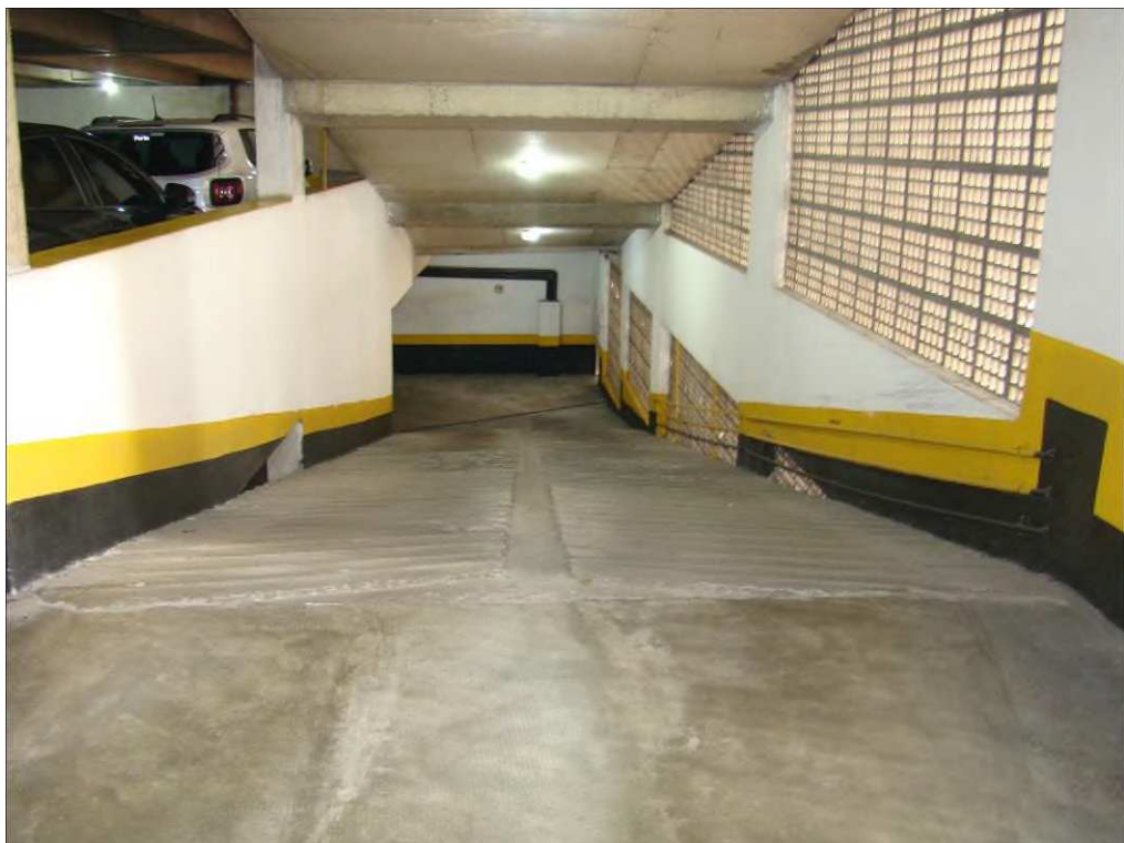
A foto ilustra a rampa de acesso ao 3º subsolo do Edifício Monte Ararat.
