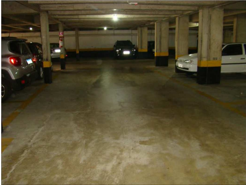
A foto ilustra a circulação de veículos no 2º subsolo do Edifício Monte Ararat.
