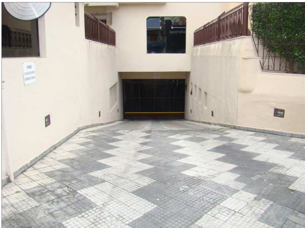
A foto ilustra a rampa de acesso aos subsolos da garagem do Edifício Monte Ararat situado na Avenida Santo Antônio nº 1.291.
