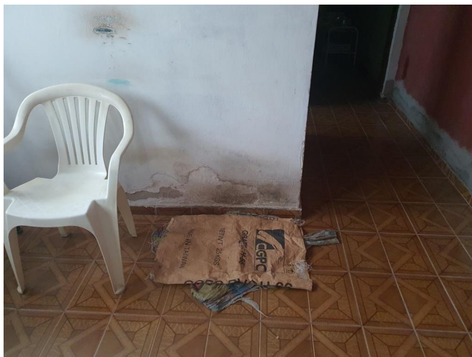
FOTO 10 – PISO E ACABAMENTO DA PAREDE COM PREDOMINÂNCIA DE INFILTRAÇÃO
